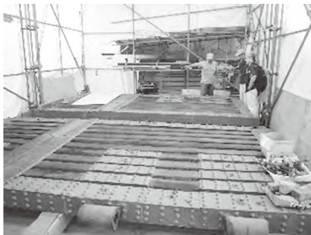
写真1 取り外された東大手門
